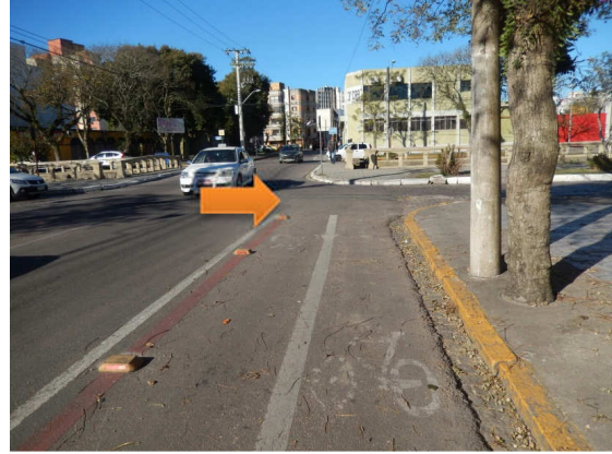
Figura 02: Fim da ciclofaixa em um perigoso cruzamento. Fonte: PRÓPRIO AUTOR (2016)
